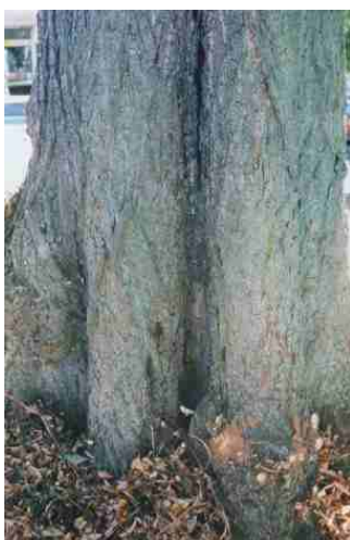
Abbildung 2 Gefahr: Fäulebedingte streifenförmige Einwallung
