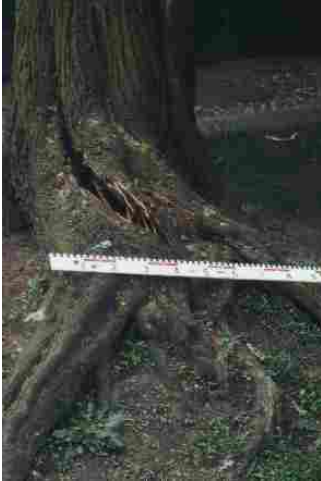
Abbildung 17 Gefahr: Angebrochener Wurzelanlauf / Stammfuß eines schiefstehenden Baumes
